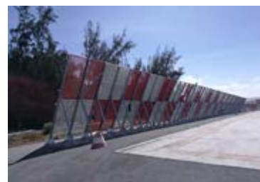
Imagen 26. Barreras anti-chorro. Aeropuerto de Gran Canaria
